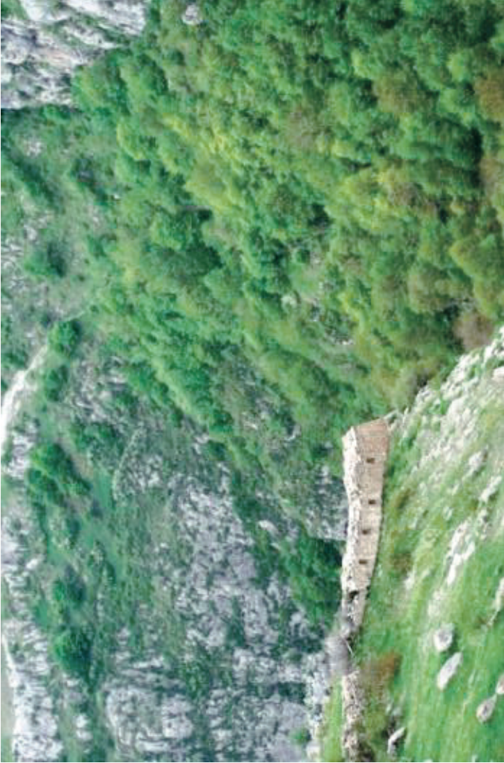
Şuşanın Potu ərazisində Qala divarının görünüşü
