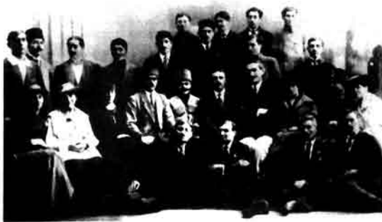
Cəfər Cabbarlının bir çox əsərləri "Hacıbəyli qardaşları" teatrında tamaşaya qoyulmuşdur
